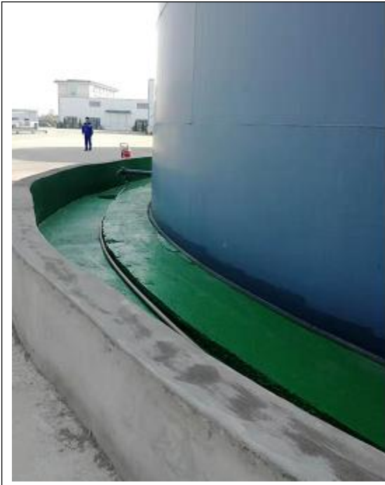
储罐区围堰
