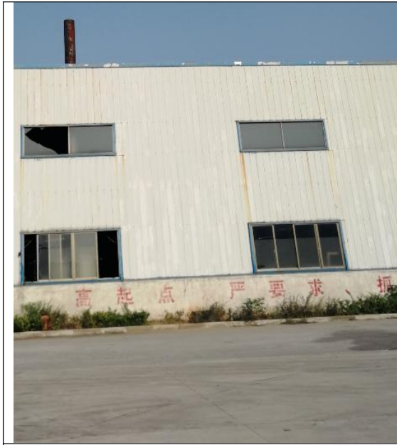
厂区地面硬化
