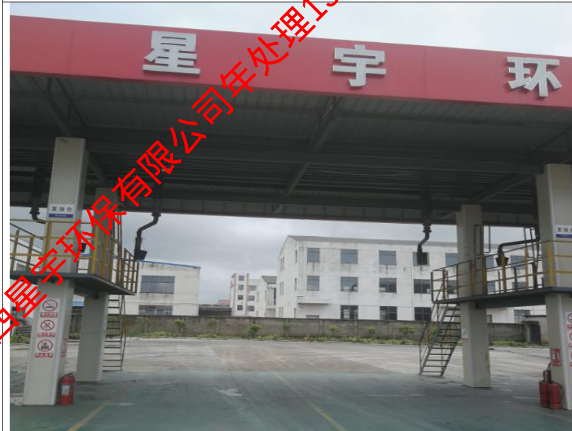
发油台现场照片
