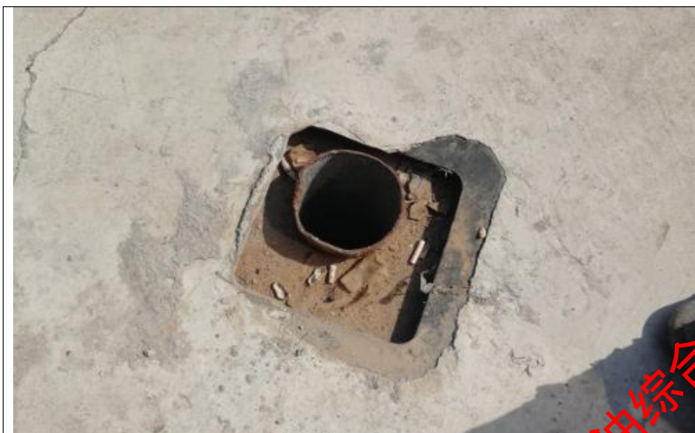
地下水监测井
