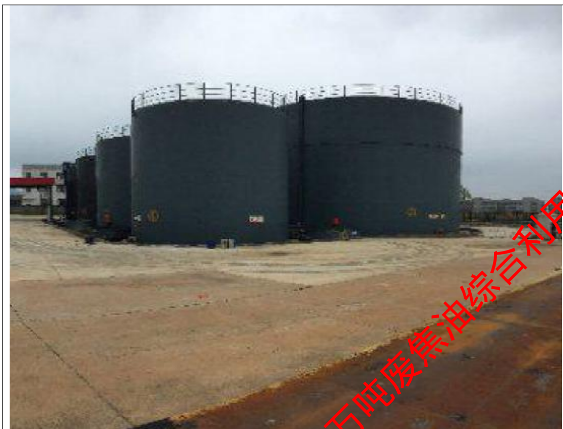
储罐区现场照片
