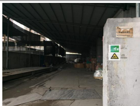
一般固体废物暂存处
