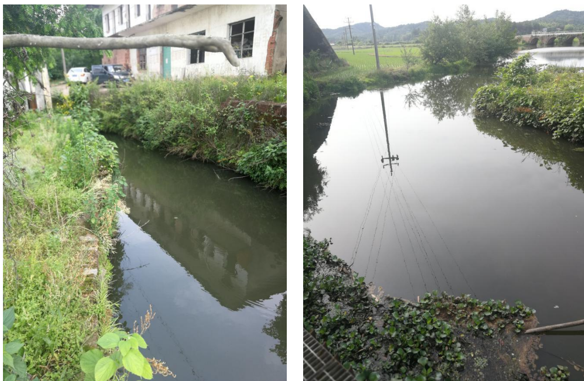
引水渠线恢复情况
