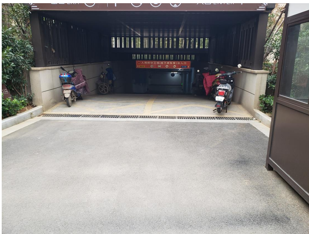
雨水管网（2020.02 月拍摄）
