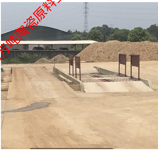
车辆冲洗平台
